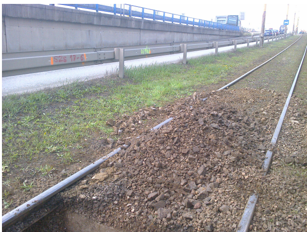
Obrázok 3 Štrk s prímiesou jemnozrnnej zeminy v sonde KS-01
