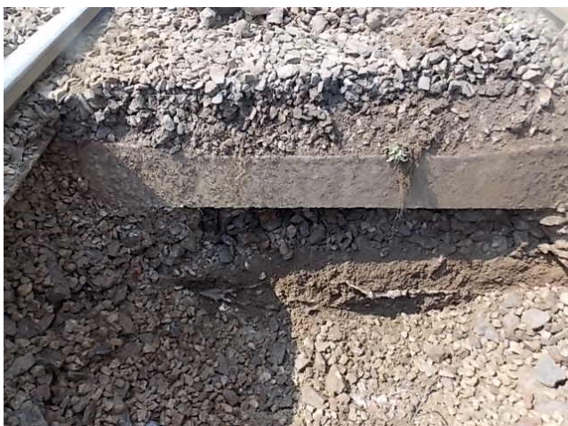
Obrázok 5 Štrk s prímiesou jemnozrnnej zeminy v sonde KS-01
